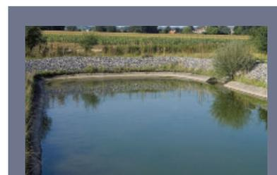
La station d'épuration des eaux usées est une station à boue activée. Le nouvel équipement utilisera le même procédé et aura la même capacité de traitement que la station actuelle. Un bassin d'orage sera aménagé en tête de station pour retenir les eaux pluviales excédentaires, mais également pour éviter les rejets d'eaux usées en milieu naturel lors de grosses averses de pluie. Ce bassin aura une capacité de 1 900 m<sup>3</sup>.
