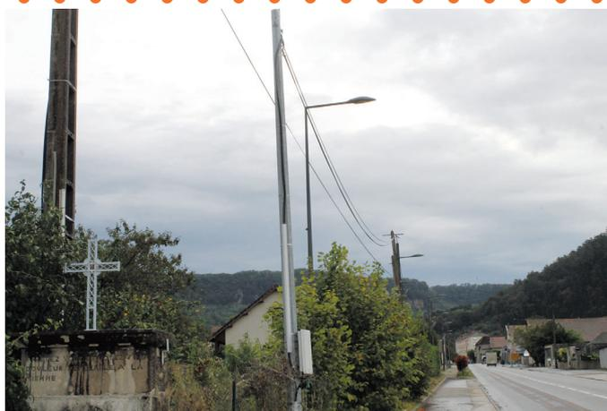
*Les travaux d'enfouissement des réseaux secs, route de Lons, touchent à leur fin. Le réseau électrique basse tension souterrain est déjà effectif et les fils ornant les anciens poteaux béton ont d'ores et déjà été ôtés.*
